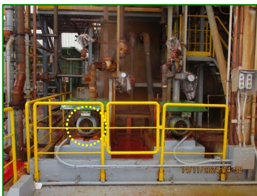
ภาพที่ 2.4 เครื่องสูบน้ำสำหรับไอกกรดของ Scrubber
