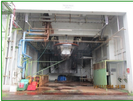
ภาพที่ 2.15 ถังเก็บ (Hopper) สำหรับรวบรวมตะกอนจากระบบบำบัดน้ำเสีย
