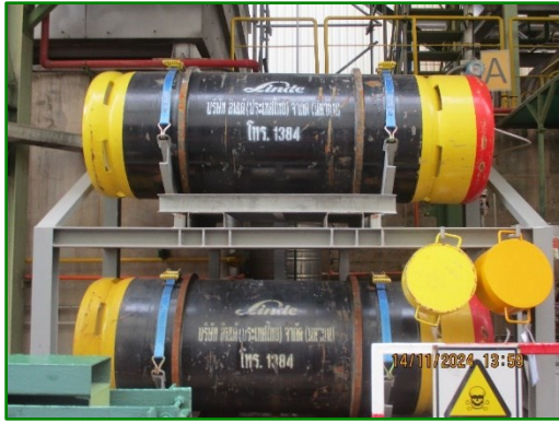
ภาพที่ 2.32 ถังจัดเก็บแอมโมเนีย ภายในโครงการฯ
